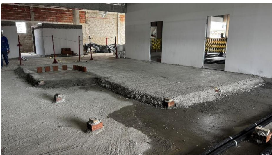
Figura 12, Instalação de contrapiso com enchimento em isopor.
