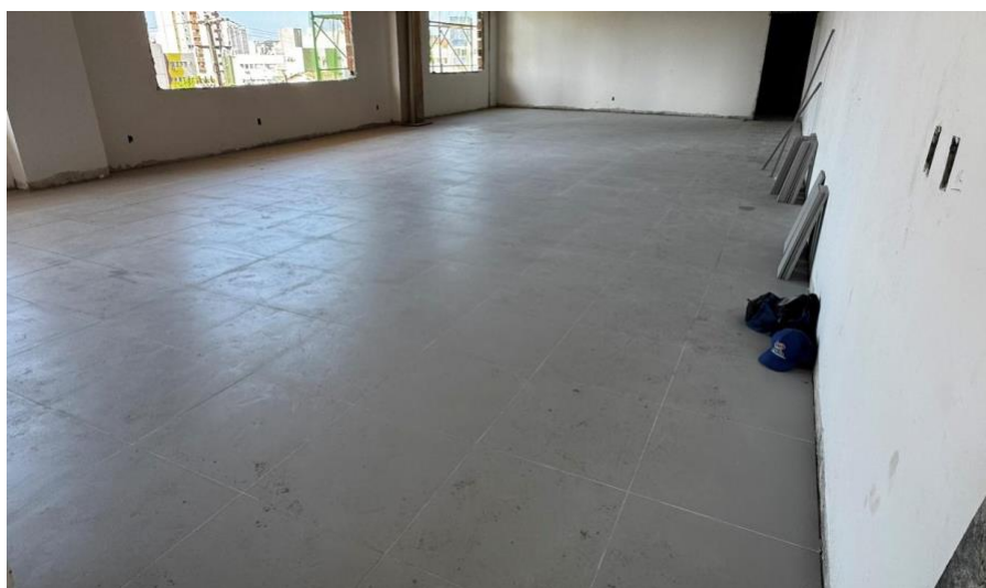
Figura 10. Instalação de piso no pavimento subsolo 1, refeitório.
