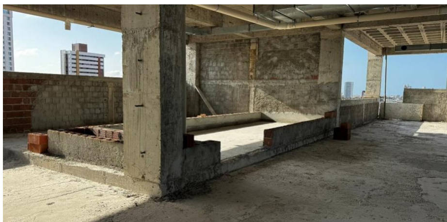
Figura 14. Execução de alvenaria com tijolos de 19cm nas salas dos fanscoils no 4º pavimento.
