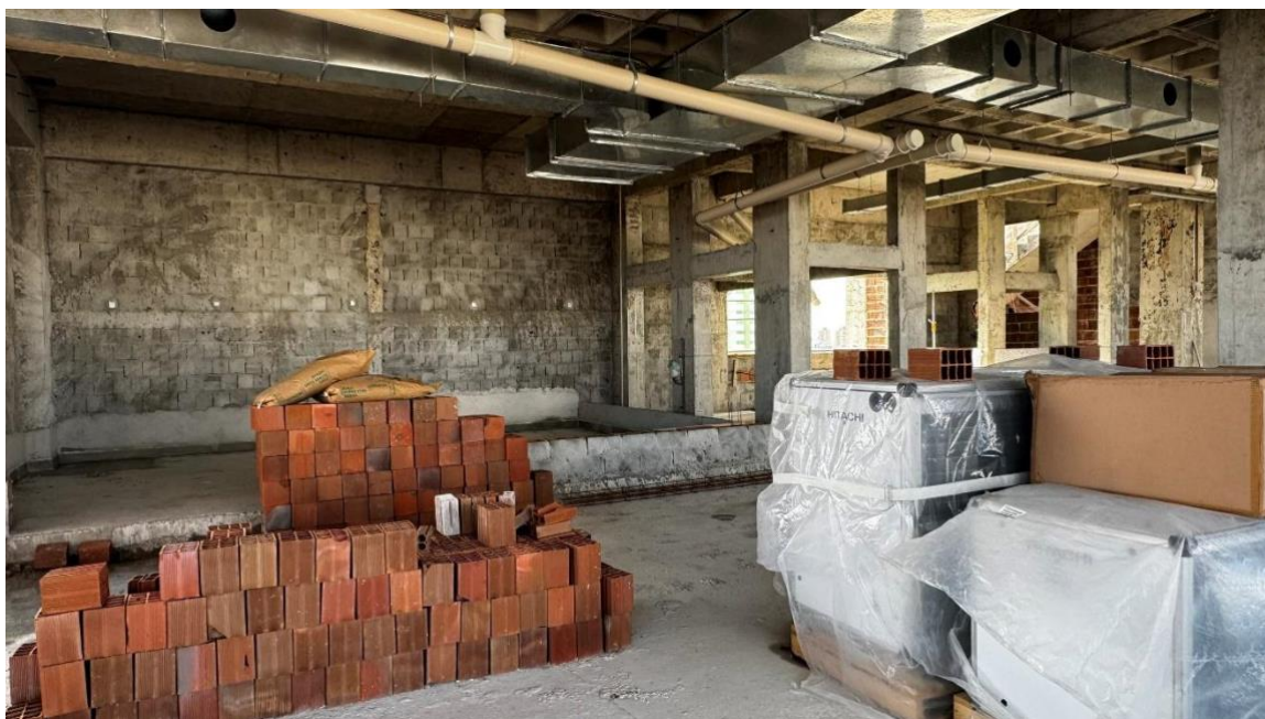
Figura 22. Tubulação de água pluvial no pavimento 4.
