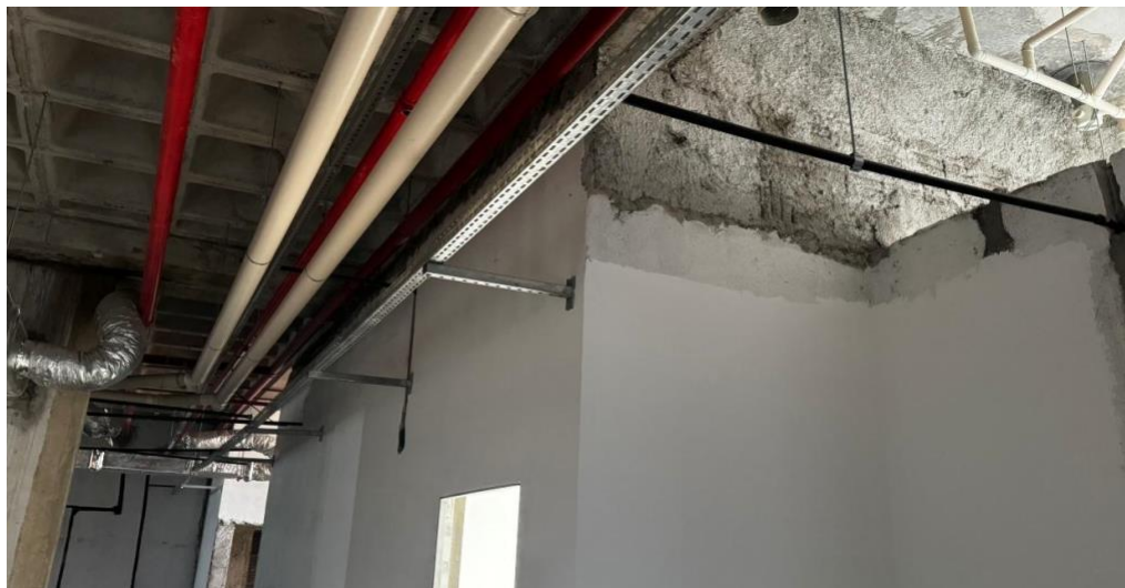
Figura 13, Paredes com aplicação de selador acrílico e massa corrida.
