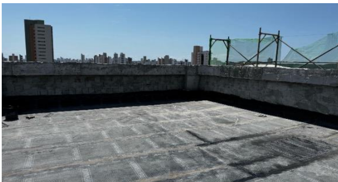
Figura 15. Execução de manta asfáltica 4mm na cobertura.
