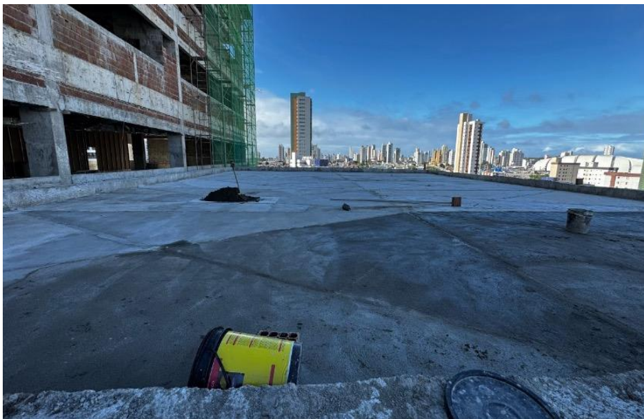
Figura 18. Execução de proteção mecânica para a manta na cobertura do auditório.
