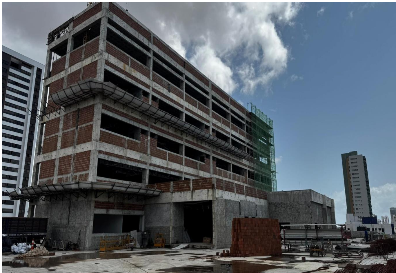
Figura 1. Visão geral da obra.
