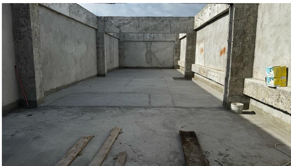
Figura 19. Execução de impermeabilização na laje dos reservatórios superiores.
