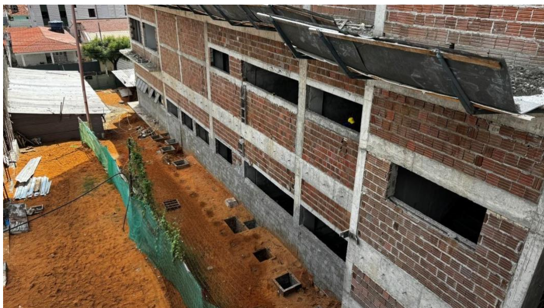
Figura 8. Execução de alvenaria com tijolos 14 x 9 x 19cm nas paredes externas, terceiro pavimento.
