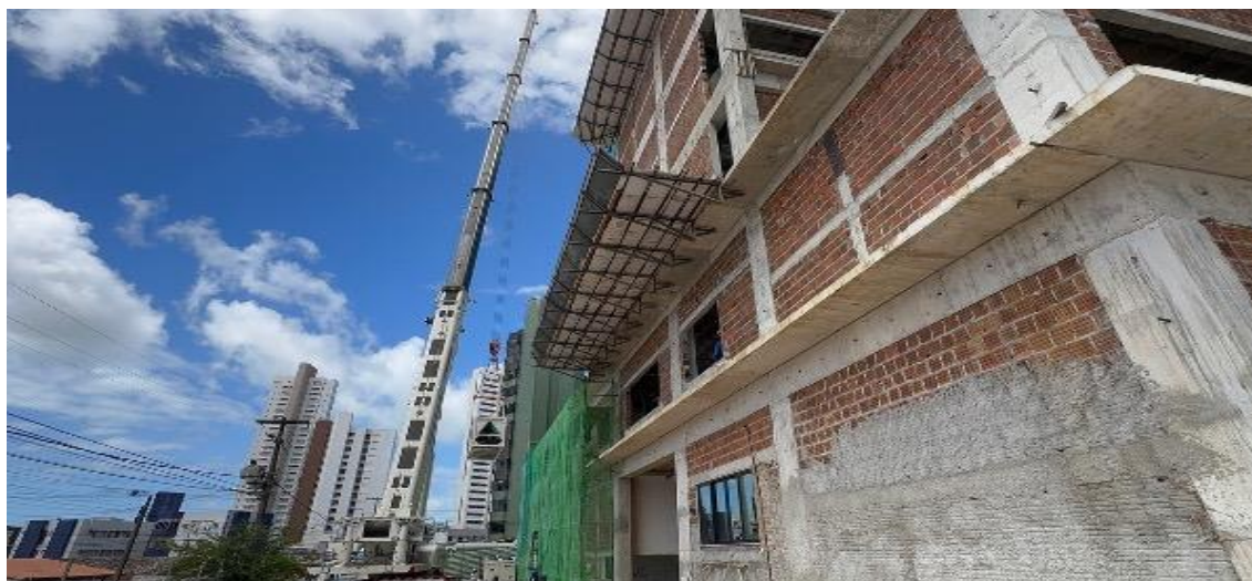
Figura 35. Içamento dos chillers para a cobertura da edificação.
