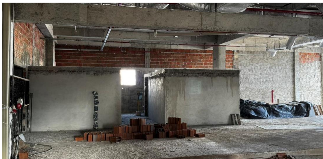
Figura 5. Elevação das alvenarias dos banheiros coletivos da recepção do térreo.
