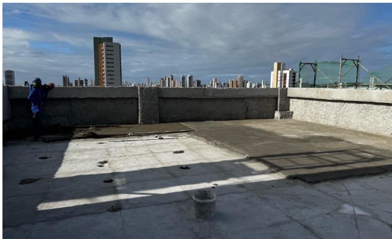
Figura 17. Execução de proteção mecânica para a manta na cobertura.
