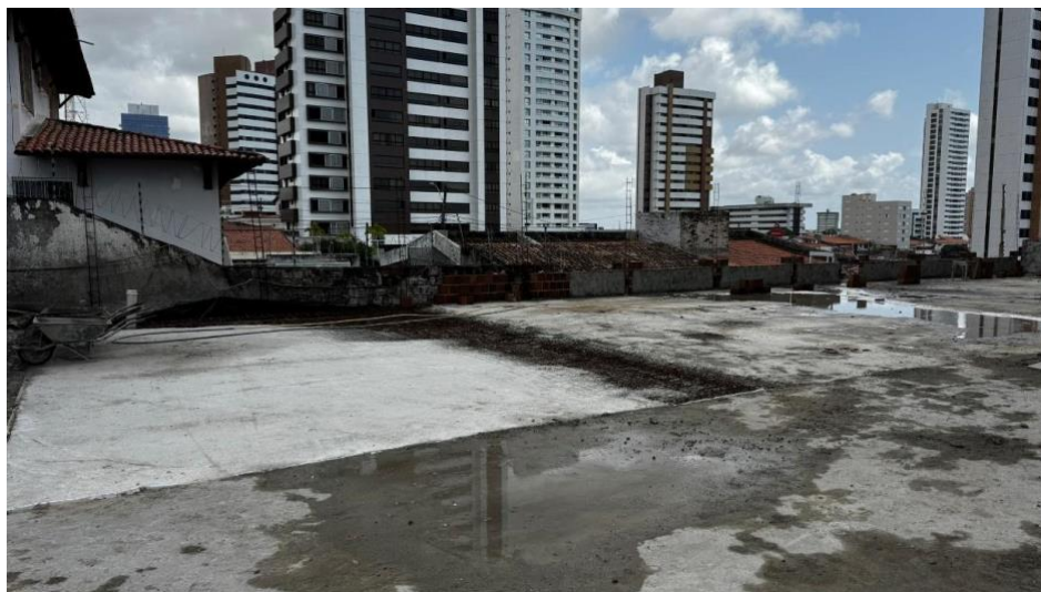
Figura 3. concretagem da laje maciça do muro em L.
