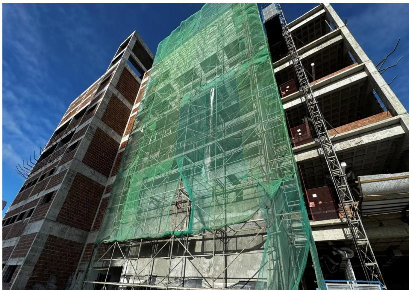
Figura 2. Andaime fachadeiro e instalação de tela de proteção.
