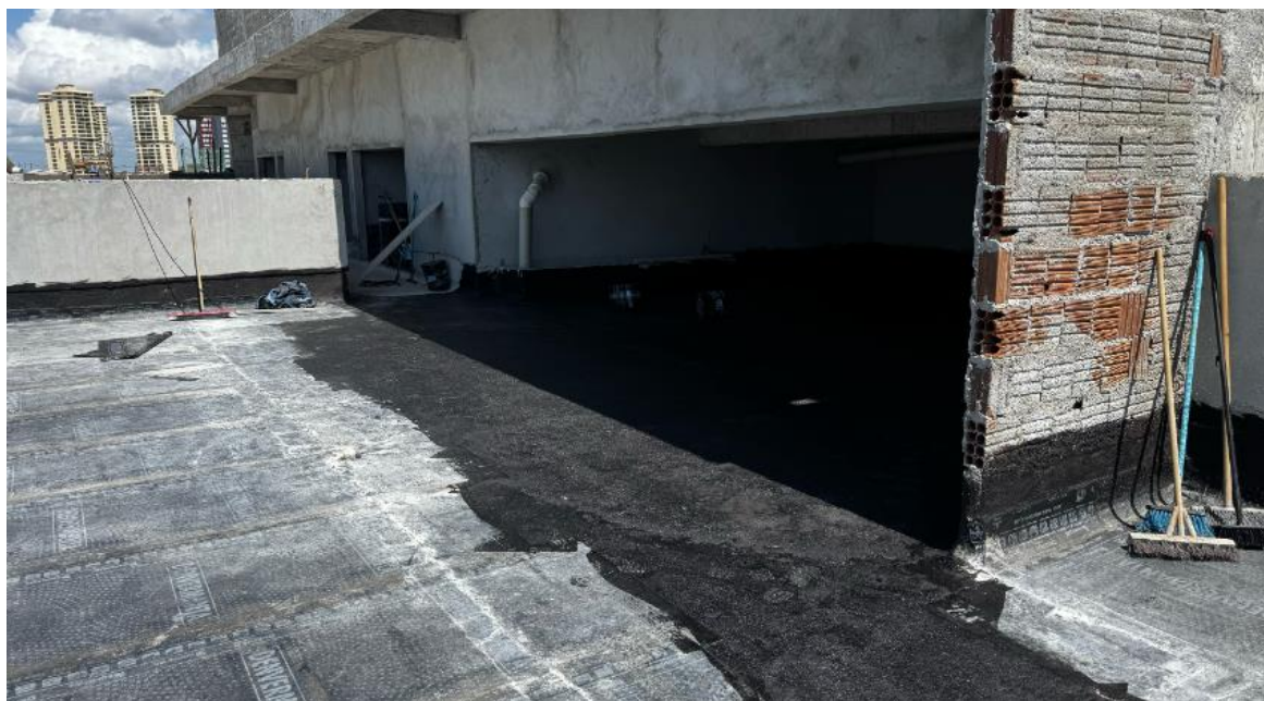
Figura 16. Execução de primer asfáltico e manta asfáltica 4mm na cobertura..
