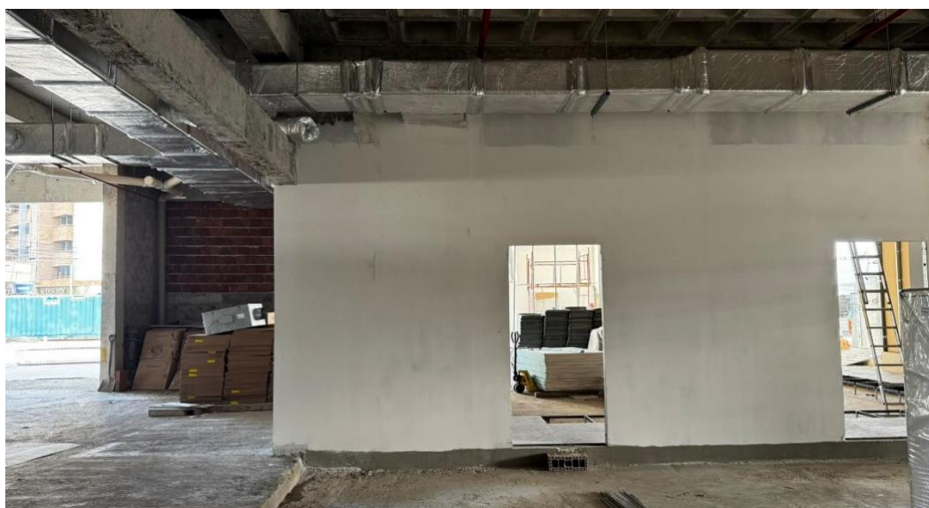
Figura 6. Instalação de paredes Drywall no pavimento térreo.
