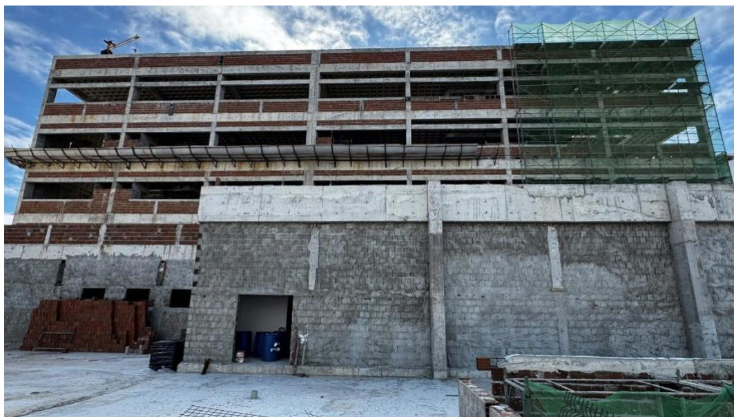
Figura 7. Fachada frontal da edificação com visualização dos pilaretes entre as alvenarias.
